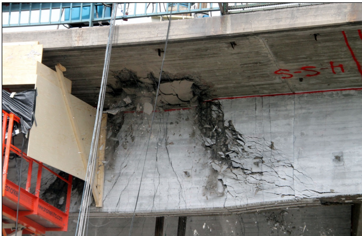
Figur 36. I slutskedet av belastningen av den södra balken uppstod skjuvsprickor.
