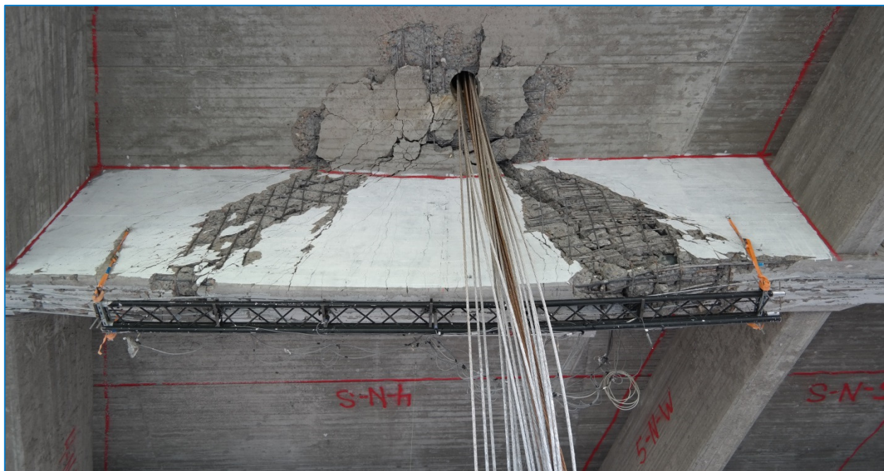
Figur 39. Brott i den mittersta balken.
