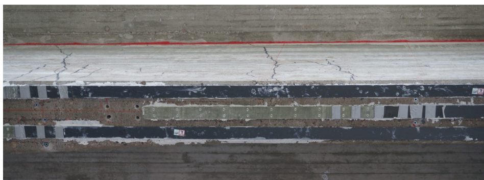
Figur 26. Förstärkningslaminat efter att förankringsanordning och tillfälliga stöddetaljer demonterats.
