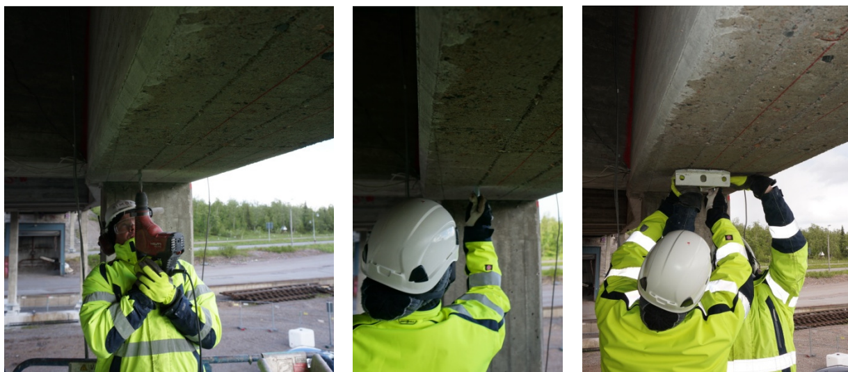
Figur 19. Borrning av hål, insättning av bult samt montering av tillfälligt stöd (förankringslåda)
