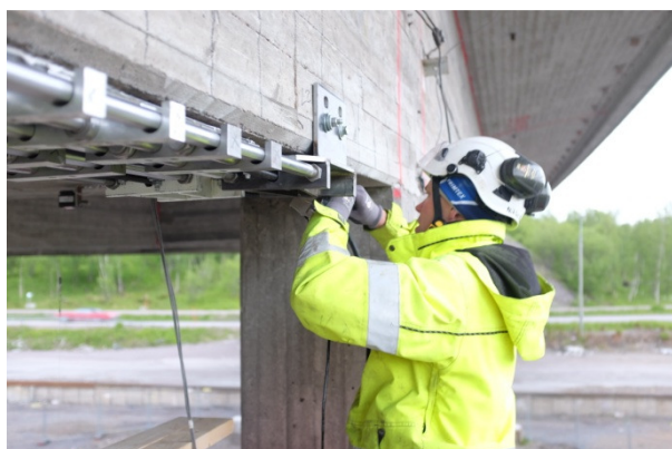
Figur 23. Montering av domkraft och lastcell för kontroll av förspänningskraft.
