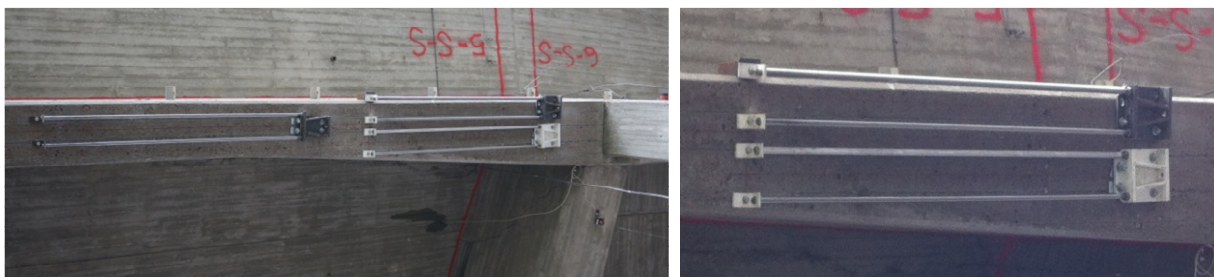
Figur 20. Samtliga tillfälliga stöddetaljer monterade vid en ände av förstärkningssystemet.
