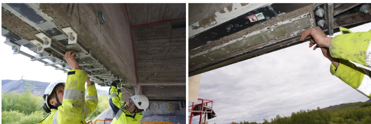
Figur 25. Demontering av förspänningsanordning och tillfälliga stöddetaljer.
