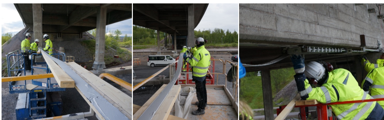
Figur 22. Montering av förstärkningslaminat mot betongbalkens undersida. Till höger, särskild noggrannhet iaktas vid monteringen av förankringsanordning.
